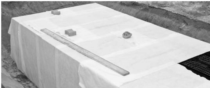
RAUSIKKO Box zariadenie obalené filtračnou geotextíliou
