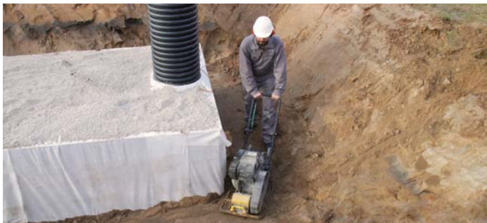
Verdichten des Arbeitsraumes
