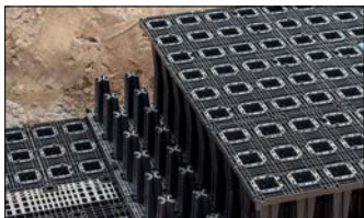
Výstavba vsakovacej zostavy pomocou „tehlového spájania“
