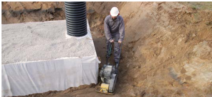
Fase di compressione del terreno di riempimento
