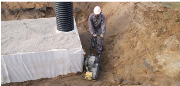
Zhutnenie pracovného priestoru
