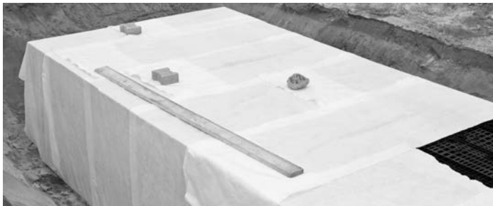
RAUSIKKO Box avec géotextile de filtration
