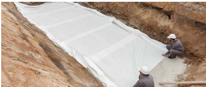
Scavo con il telo geotessile steso
