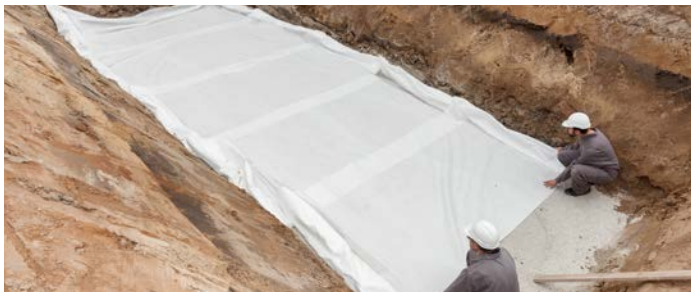
Pripravený výkop s filtračnou geotextíliou
