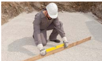
Pripravená stavebná jama
