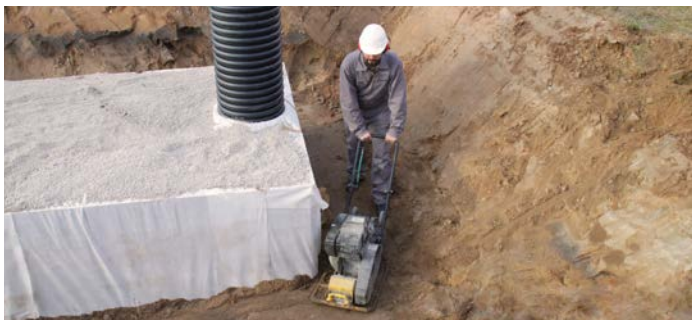
Zagęszczanie obsypki bocznej
