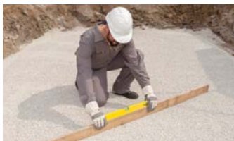
Preparazione dello scavo
