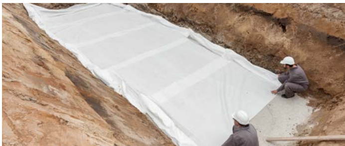
Baugrube mit ausgelegter Vliesbahn
