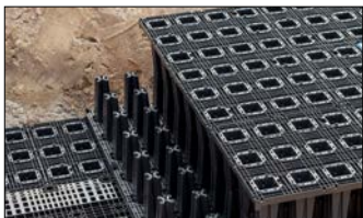
Structure de la rigole avec canal de rinçage dans l'assemblage de maçonnerie
