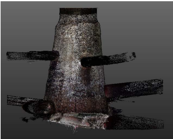
Konischer Betonschacht mit vielen versetzten Zuläufen
